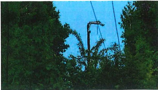
Un des pylônes 20 000 volts cisailé après la chute d'un arbre sur les lignes
