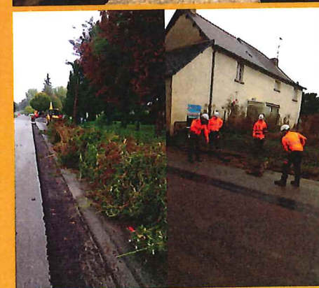
Travaux rue du Porhoët
